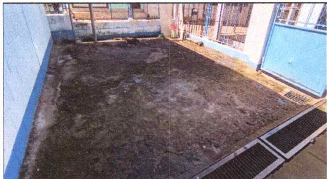
Foto 3: MÓDULO II. PATIO: Sustitución de piso de torta de concreto por torta de concreto. 19 bolsas de cemento regional 5000 PSI, 2 metros cuadrados de arena de rio, 2 metros cuadrados de piedrincillo.
