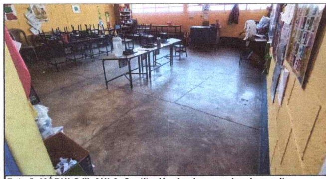
Foto 5: MÓDULO III. AULA: Sustitución de piso por piso de granito
