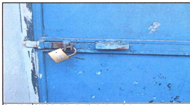
Foto 12: MÓDULO II y III. Sustitución de chapas 3 chapas para puerta marca yale
