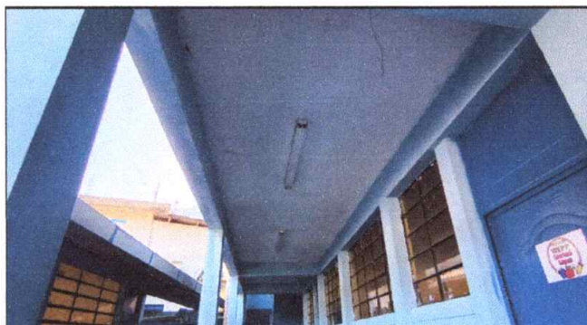
Foto 10: MÓDULO I y III. REPARACIÓN DE SISTEMA ELÉCTRICO: Sustitución de 12 plafoneras, 12 focos ahorradores, 10 sustitución de lamparas tipo led, interruptores dobles y tomacorrientes y reparación de
