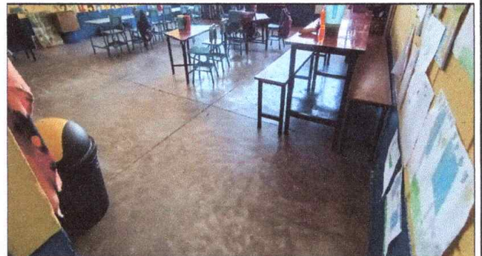
Foto 4: MÓDULO III. AULA: Sustitución de piso por piso de granito
