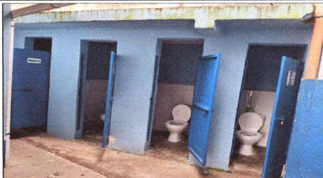
Foto 8: MÓDULO I y III. SERVICIOS SANITARIOS: Sustitución de piso por piso de granito
