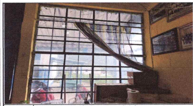
Foto 11: MÓDULO III. Sustitución de ventana y balcón para ventana
