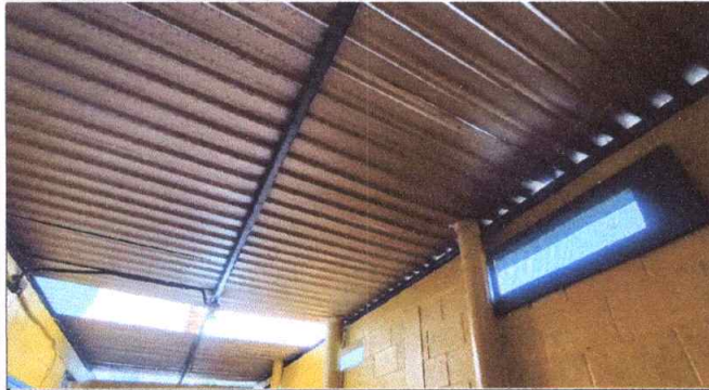
Foto 1: MODULO I. COCINA: Sustitución de lamina por lámina troquelada aluzinc calibre 26 y reforzamiento de soporte de metal. Con 2 tubos rectangulares chapa 18, 3 costaneras chapa 18, 1/4 de pintura r15 azul
